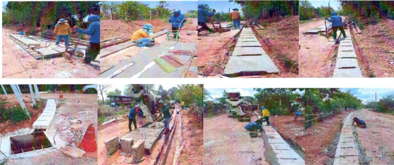
ภาพ ขณะดำเนินการ โครงการก่อสร้างรางระบายน้ำรูปตัวยู หมู่ที่ ๘ สายสามแยกบ้านนางยุพิน มงคล(ข้างโรงเรียน)ถึงสามแยกบ้านครุกาญจนา วงค์ศรีซา
